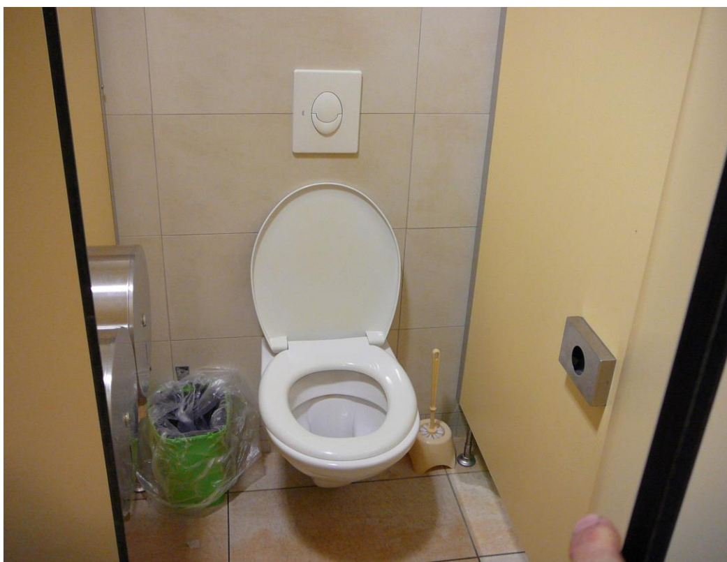
Obrázek 6 - toaletní mísy v kabinkách a vybavení
