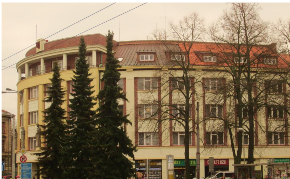
Oprava střechy domu Kotěrova, Divišova 828 - 830
