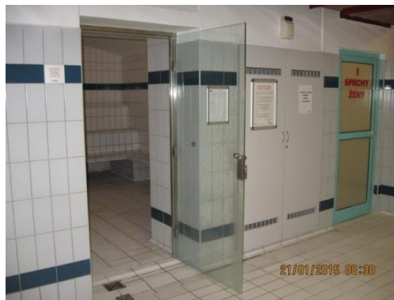
nové prosklené dveře do parní komory
