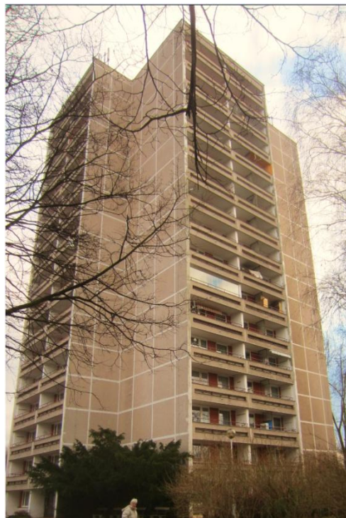
výměna oken bytového domu Jungmannova čp. 1437
