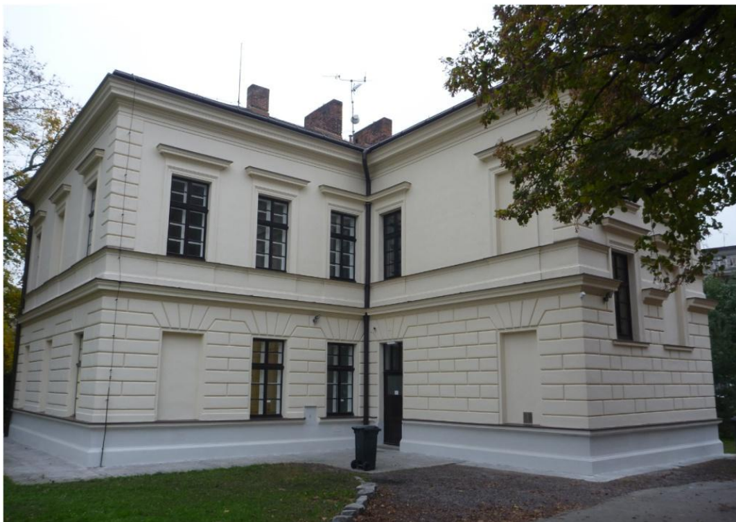
Oprava fasády a nátěr oken objektu Československé armády 332 – Boni Pueri
