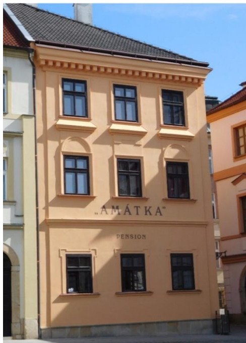
Malé náměstí 120 - AMÁTKA - odstranění zemní vlhkosti, oprava fasády a nátěr oken
