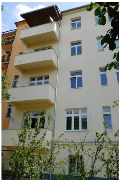
Šafaříkova 764 - oprava fasády a dvora včetně kanalizace
