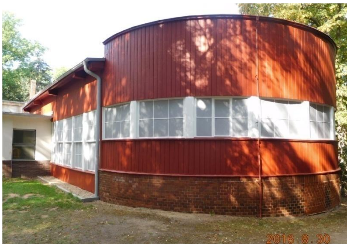
Jiráskovy sady 237 – oprava oken a opláštění
