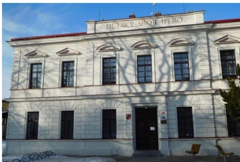
Československé armády 335 - oprava fasády a nátěr oken
