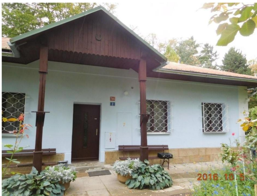
Jiráskovy sady 785 - oprava fasády
