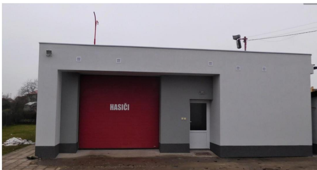
Cimlerova 37 – zateplení fasády a střecha hasičské zbrojnice
