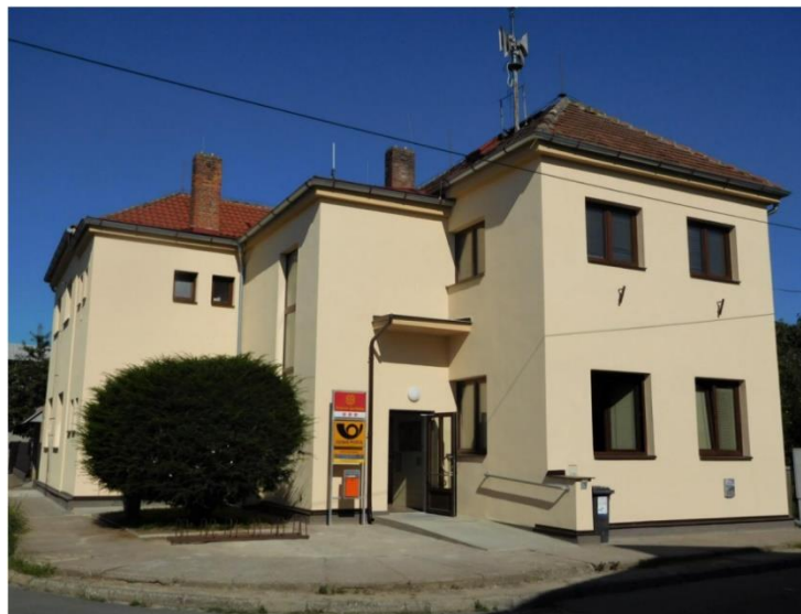
Poštovní 45 – oprava fasády a výměna oken
