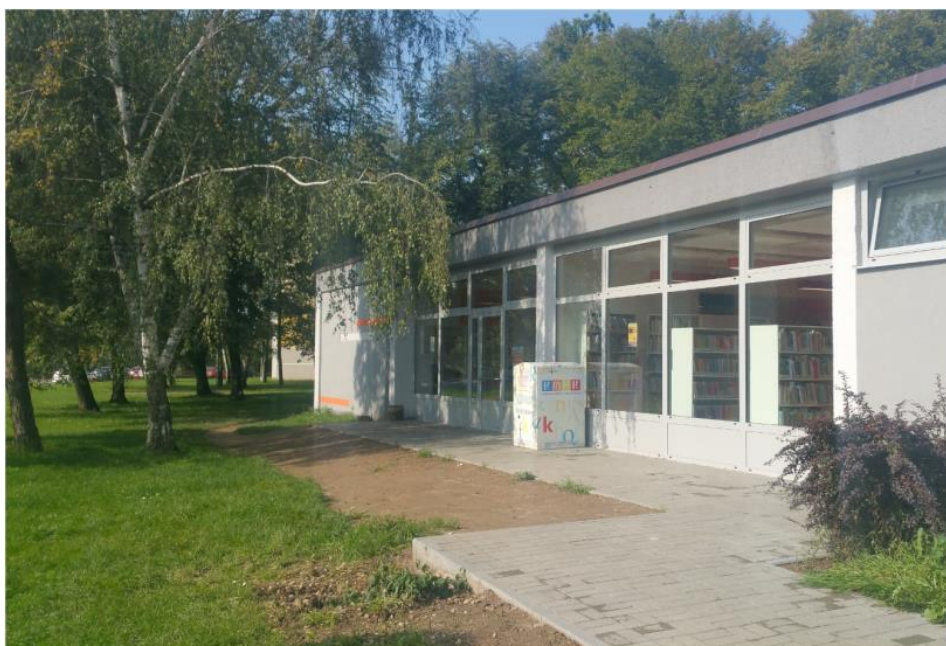
Gagarinova 844 – městská knihovna - výměna výloh a stavební úpravy
