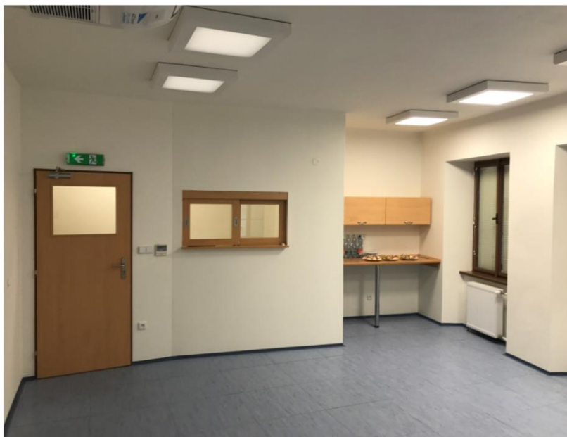
Dlouhá 211 – Městská policie – stavební opravy interiéru domu - I. etapa
