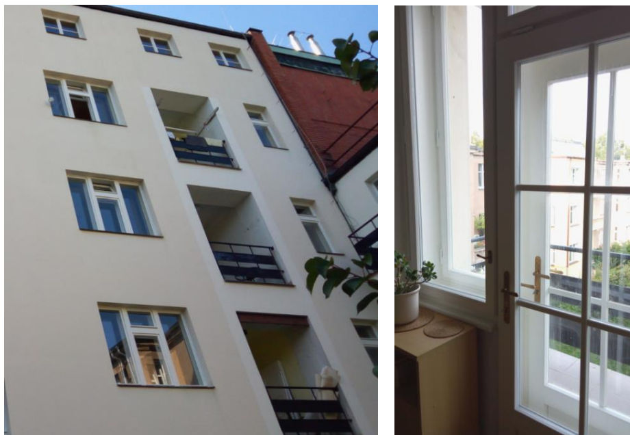
nám. Osvoboditelů 820 – výměna špaletových oken
