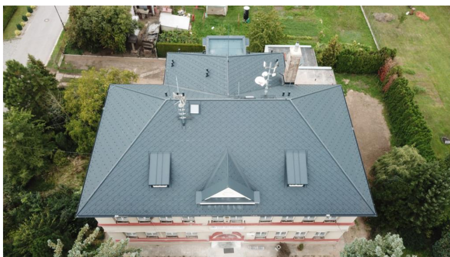
Černilovská 7 – oprava střechy
