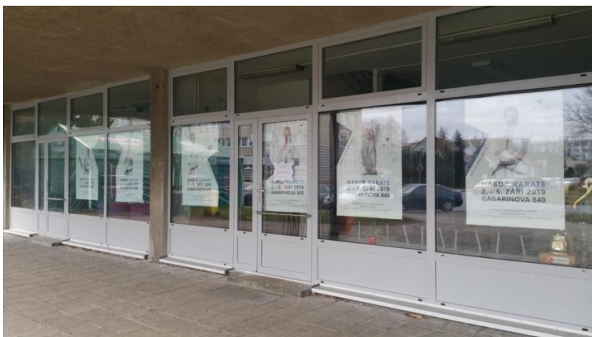
Gagarinova 840 – výměna výloh a oken
