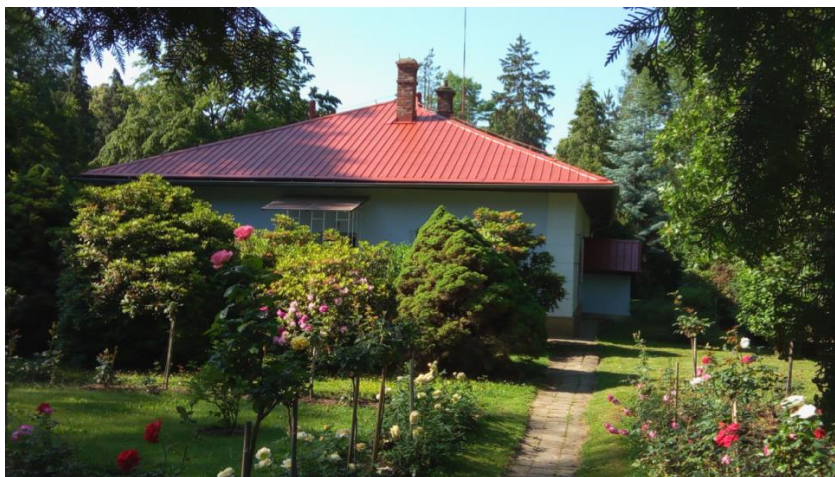
Jiráskovy sady 785 - nátěr střechy
