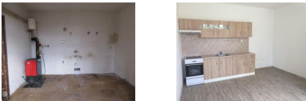
Denisovo náměstí 585 – oprava bytu (před a po)
