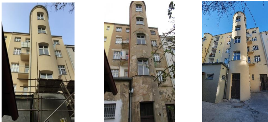
Mánesova 780 – oprava dvorní fasády (před a po)
