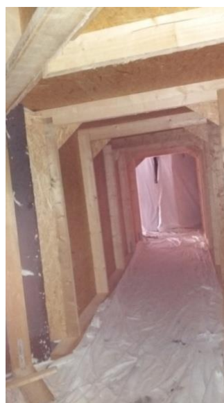
dočasná ochranná konstrukce uvnitř divadla
