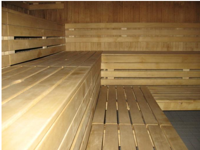
sauna - výměna sedáků a přebroušení obložení stěn, stropů a vstupních dveří
