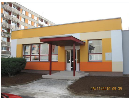
generální oprava objektu Formánkova č.p.437
