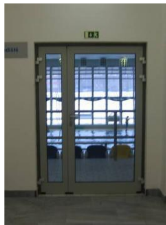
nové prosklené dveře na galerii nad bazénem
