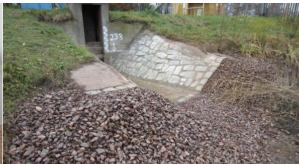
opravené vypouštěcí zařízení
