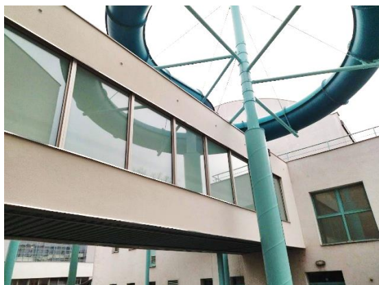
nátěr kovové konstrukce tobogánu a nová fasáda a okna na spojovací chodbě
