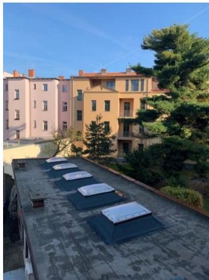
Výměna střešních světlíků nad přízemní dvorní přístavbou domu Švehlova 393 (stav před a po)
