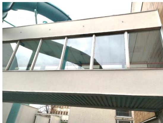
nátěr kovové konstrukce tobogánu a nová fasáda a okna na spojovací chodbě
