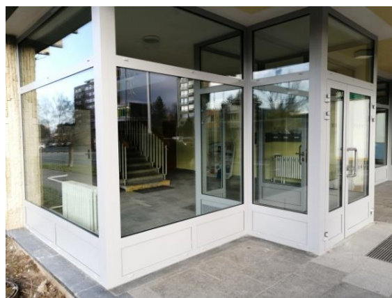
M. Horákové 504 – výměna vstupních portálů
