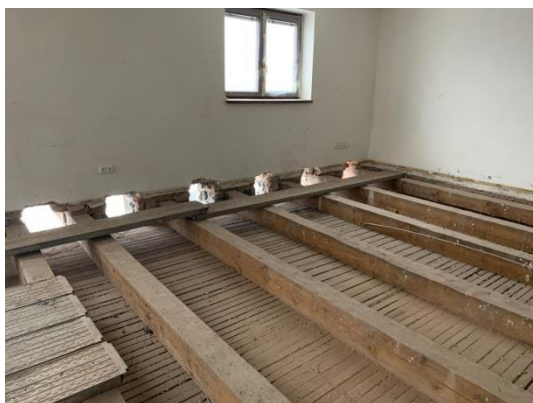
KMS Březhrad – realizačně náročné zvýšení nedostatečné únosnosti podlahy vložení ocelových nosníků
