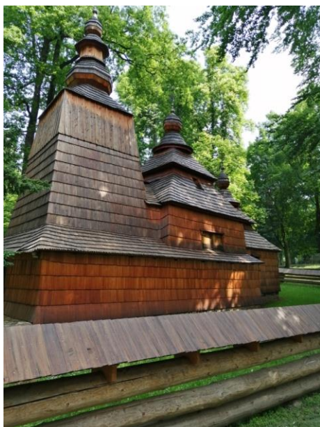
Jiráskovy sady – nátěr šindele na kostele pro prodloužení životnosti a výměna části areálového rozvodu vody
