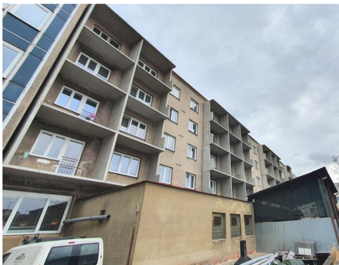
dům SVJ Průmyslová 1196–1198 - nové prefabrikované lodžie do dvora
