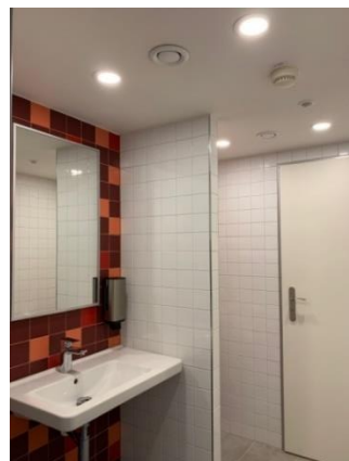
soc. zař. v provozní budově
