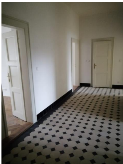
opravená chodba v bytě vč. původních dveří a dlažby
