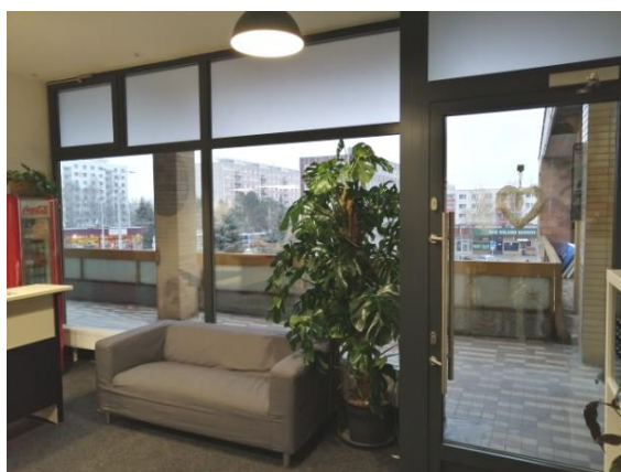
M. Horákové 549 – výměna výloh vč. dveří ve 2. NP
