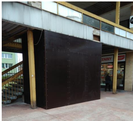
M. Horákové 549 – provizorní zajištění ocelové konstrukce
