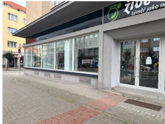
část severní strany vyměněných výkladců vč. vstupních dveří
