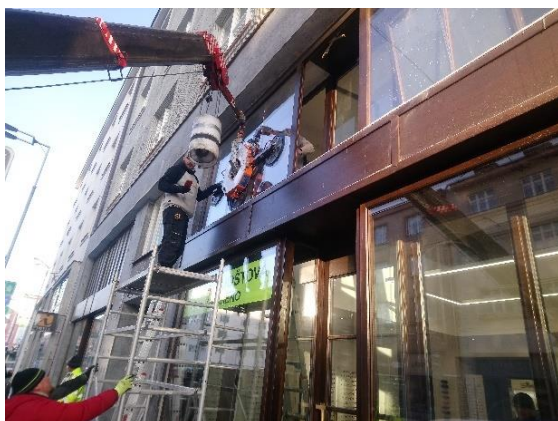
náročná výměna atypických dřevěných výloh
