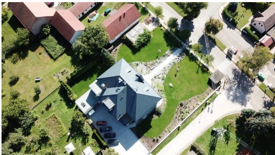
letecký pohled na školu po celkové rekonstrukci včetně nové zeleně a zpevněné plochy dvora
