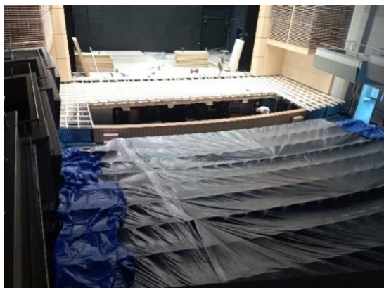
průběh výměny parketové podlahy jeviště
