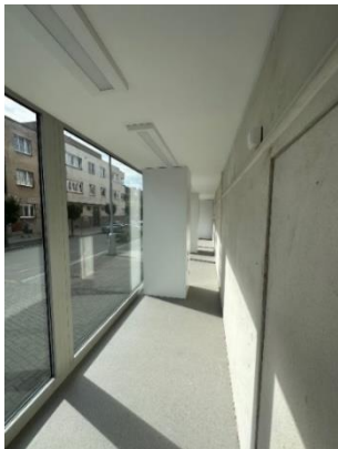
opravený vnitřní prostor výkladců
