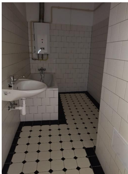
koupelna opravená dle historické dokumentace a požadavku OPP
