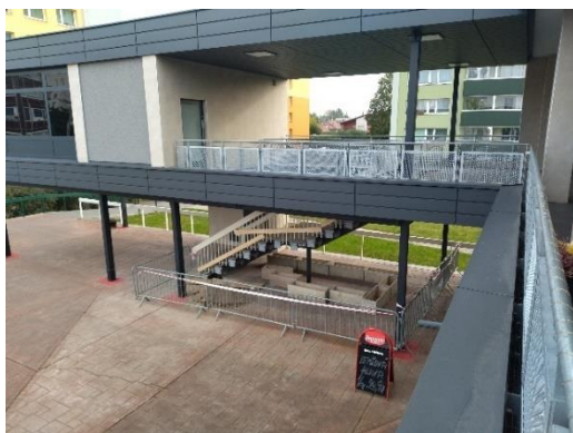
zřízení schodišťové plošiny – rozpracovanost
