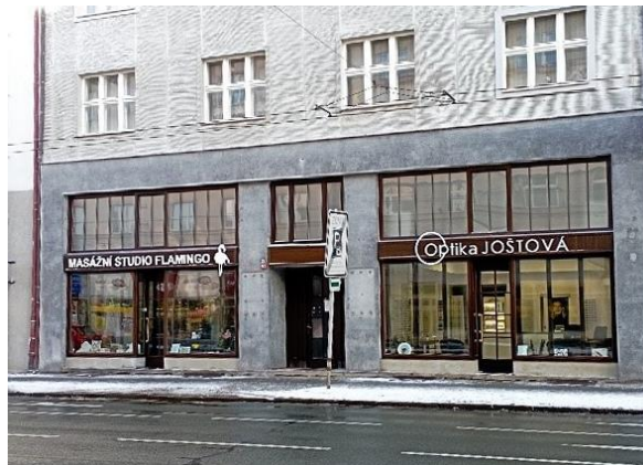
vyměněné výlohy a okno nad vstupem do bytového domu
