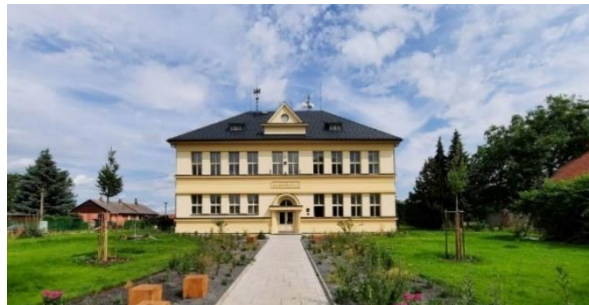
opravená budova školy
