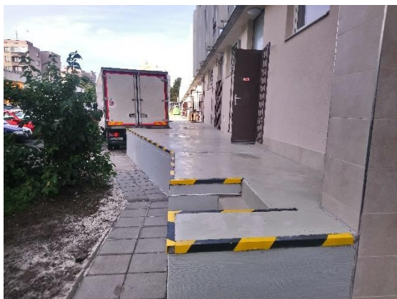
nákladová rampa po opravě – jižní strana
