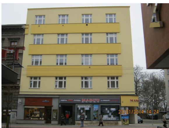
Oprava fasády Dukelská čp.812
