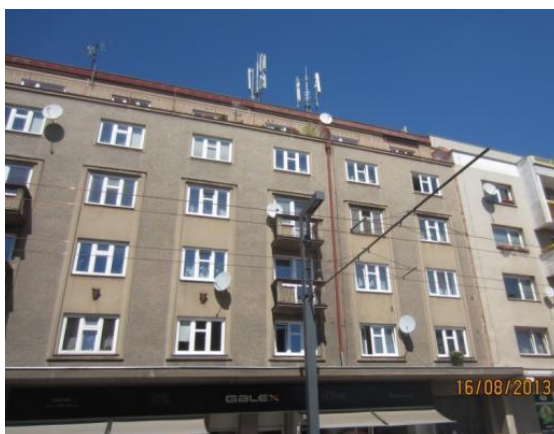
Výměna oken bytového domu Dukelská čp.11
