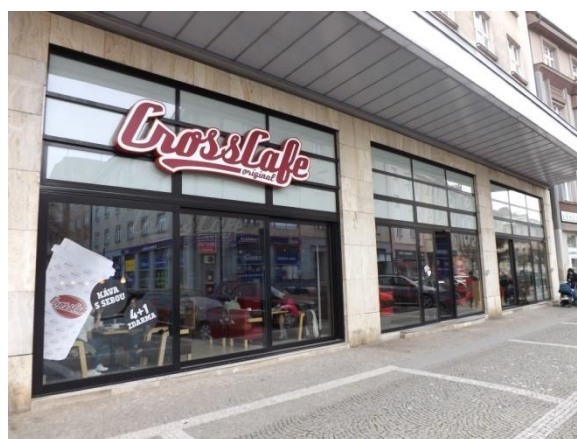
Výměna otevíracích výkladů Gočárova tř. čp. 761
