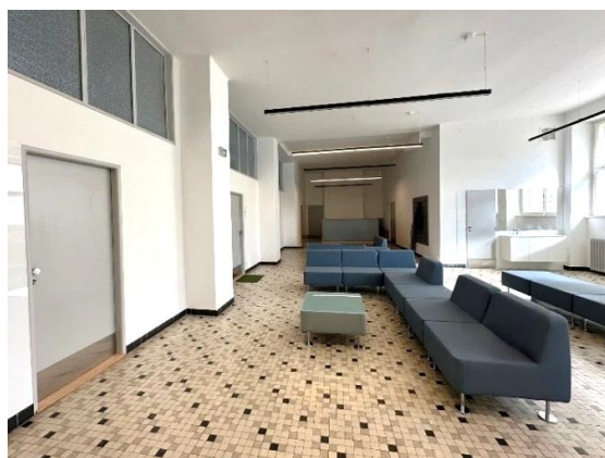
oprava vestibulu u ordinací lékařů
