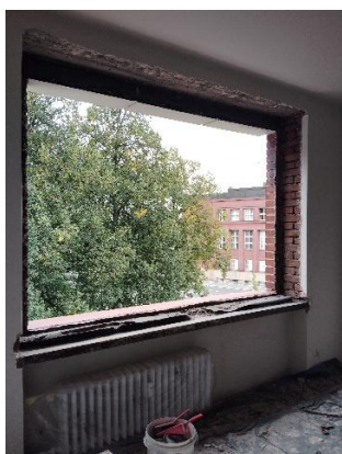
provádění – vybourané okno
