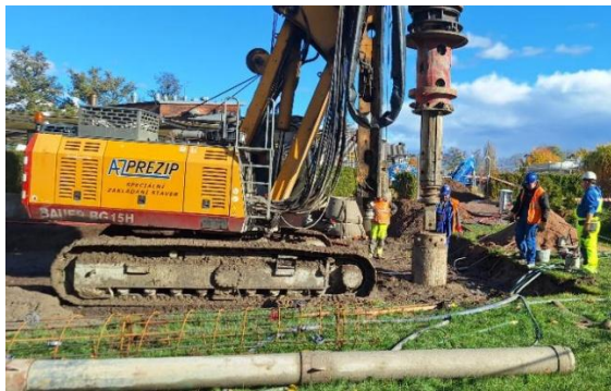
novostavba toalet na koupališti Flošna – založení stavby na pilotách
