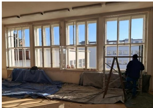
V Liptkách 692 – výměna oken v učebnách
