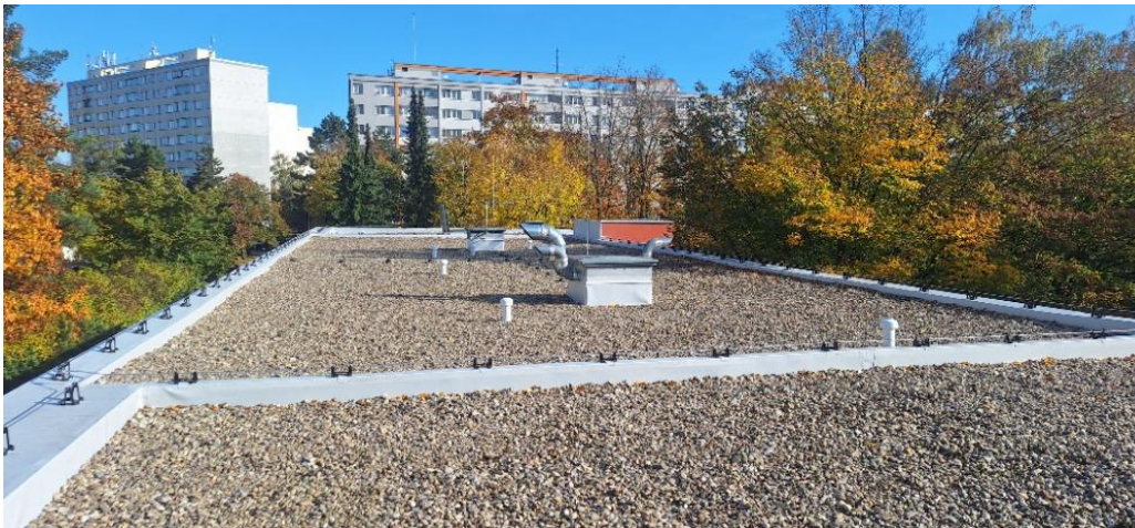
nová střecha na objektu DANETY
