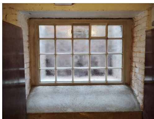
vyměněné okno ze sklepa do anglického dvorku
