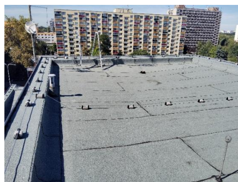
část opravené střechy
