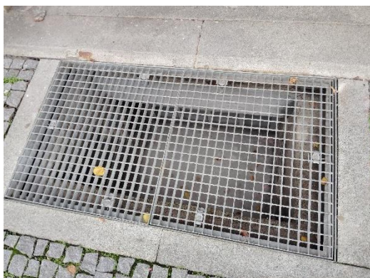
vyměněná mříž v chodníku nad opraveným anglickým dvorkem
